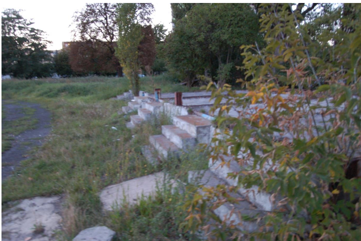
II.8. Dewastacja powierzchniowa – pozostałości fundamentów.
